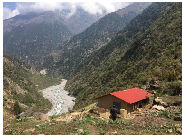
Abb.: Ein einstöckiges Haus unmittelbar nach der Fertigstellung
